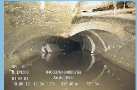
Gebrochene Niederschlagswasser-Betonleitung
