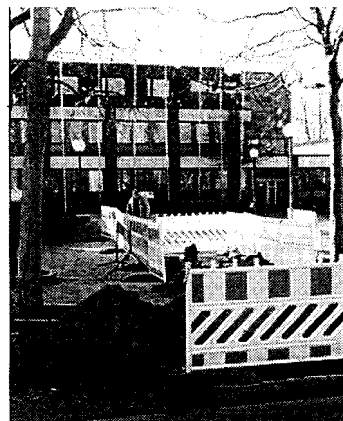
Baustelle vor der Trittauer Verwaltung: Hier wird die Datenleitung zum Zweckverband verlegt.
