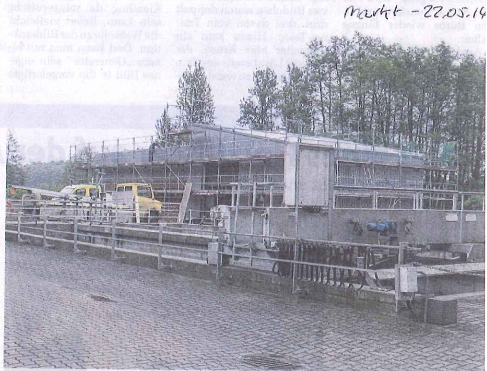
Nach dem Richtfest wird in und an der neuen Halle eifrig gearbeitet.
